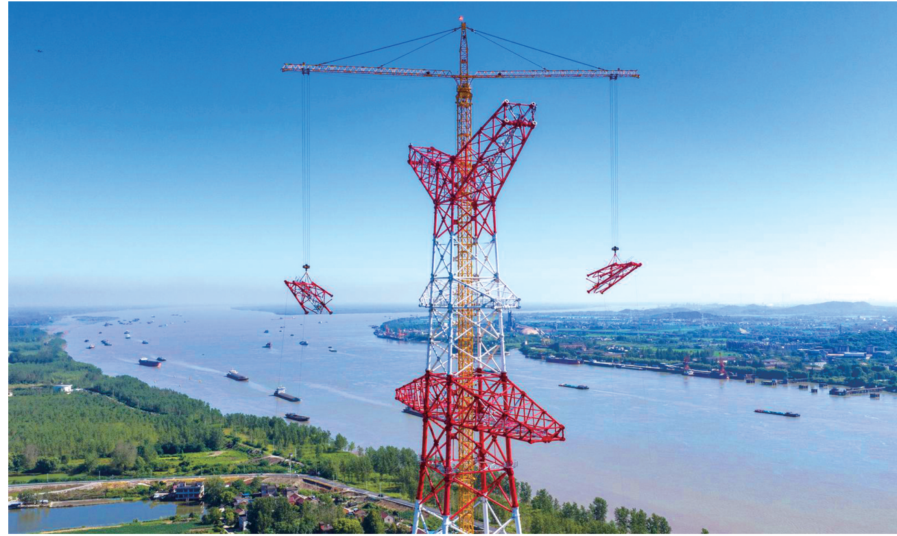
8月26日,在安徽芜湖无为市高沟镇的长江边,经过建设者69天的施工,“西电东送”重点工程——甘肃—浙江±800千伏特高压直流输电工程长江大跨越196米高的北岸输电塔顺利封顶。甘浙特高压工程是国家电力发展规划重点项目,起于甘肃省武威市,止于浙江省绍兴市,全长2370公里,投运后每年可向浙江输送电量超360亿千瓦时。
