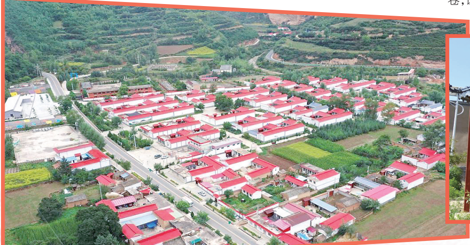
济南市钢城区、莱芜区援建的東西协作示范村——康乐县莲麓镇足古川村。
