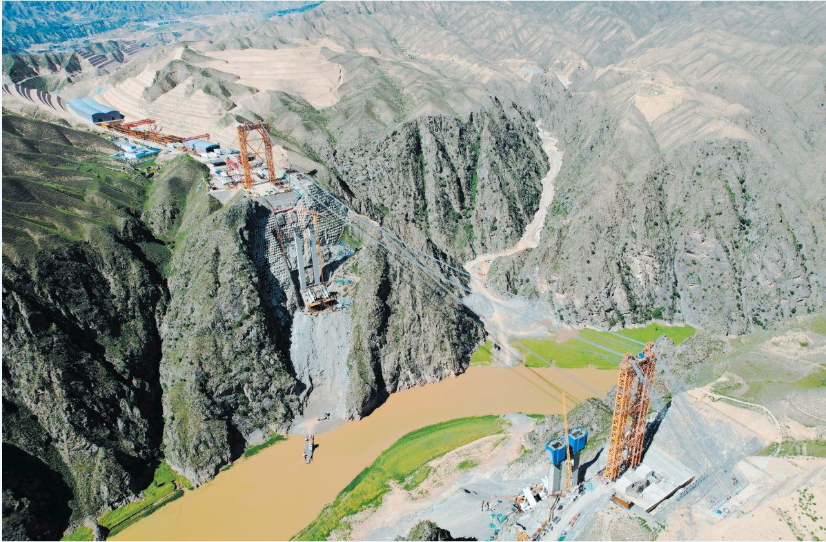
兰永临高速公路洮河特大桥
