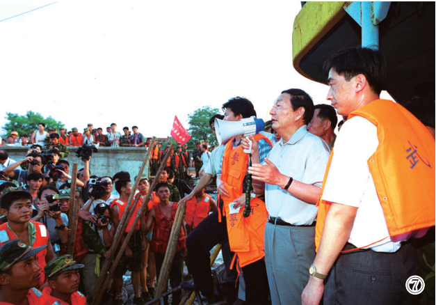
图⑦:1998年8月9日,朱镕基同志在江西省九江市防洪墙堵口现场指挥抗洪抢险工作。
