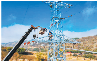
工作人员开展隐患排查作业
