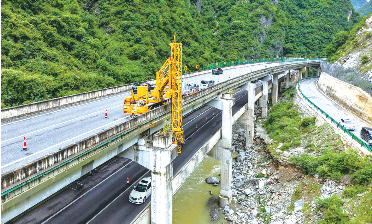
8月2日,在陇南市武都区枫相乡附近,工作人员对兰海高速武墩段一座双层高架桥进行桥梁检测(无人机照片)。7月29日到8月2日,甘肃省陇南市普降大到暴雨,局地出现大暴雨。为应对严峻汛情形势,陇南市启动防汛抗洪二级应急响应。各县区、各部门全力开展隐患排查、基础设施抢修等工作,守护群众生命财产安全。 新华社记者 郎兵兵 摄
