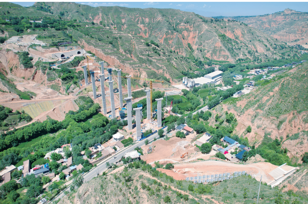
兰永临高速公路11合同段春台大桥建设项目全长574.5米，两端分别与东乡1号、2号隧道相接。目前，该项目90根桩基、16个承台已全部建成，薄壁空心墩、盖梁等工程加紧建设中，项目进展顺利。 临夏融媒记者 梁永吉 摄
