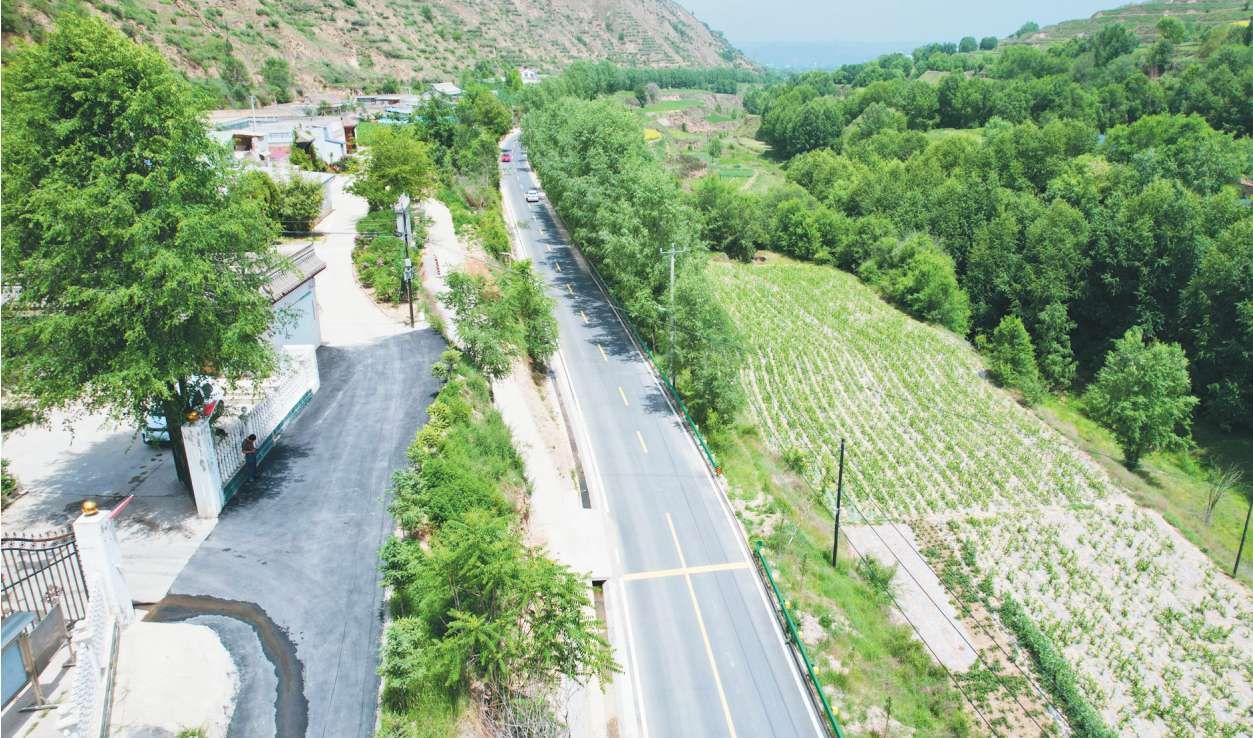
临夏县井沟乡至北塬镇道路提升改造项目线路总长13.6公里，估算总投资1350余万元。近日，项目顺利竣工、全线通车，有效改善井沟乡、北塬镇以及积石山县银川镇、铺川乡沿线群众出行条件。
