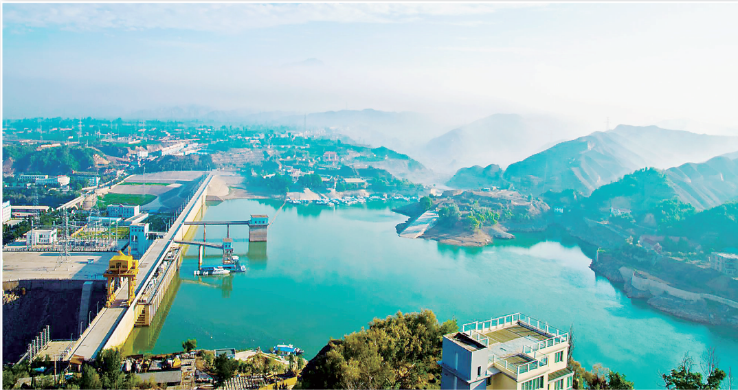
刘家峡水电站
