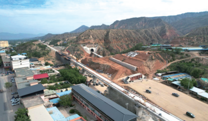
尕常村环绕右线特大桥建设现场
