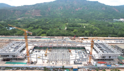
临夏站建设现场
