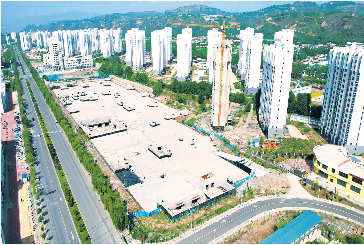
临夏县东区体育公园地下空间综合利用项目总建筑面积3.6万平方米,总投资1.67亿元。目前项目主体已完工,正在进行顶板防水施工,整体进展顺利。 临夏融媒记者 梁永吉 摄
