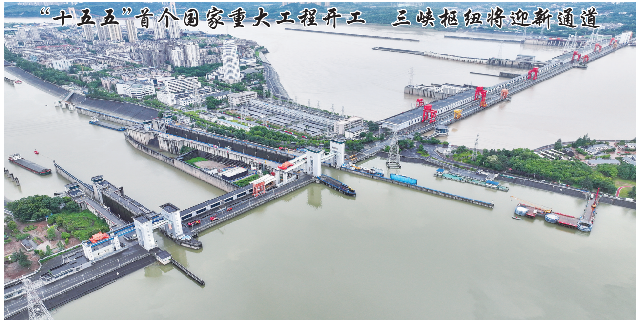
6月8日，我国“十五五”期间开工建设的首个国家重大标志性工程——三峡水运新通道破土动工，有利于提升长江黄金水道通航能力。总投资约772.08亿元的三峡水运新通道工程，由两部分组成。其中，三峡枢纽新通道位于已建三峡船闸北侧，规划新建双线连续五级船闸，线路长约6680米，工期为112个月（含12个月工程筹建期）。葛洲坝航运扩能拆除既有三号船闸，新建两线单级船闸，并对上下游引航道进行扩挖，工期为95个月（含12个月工程筹建期）。
