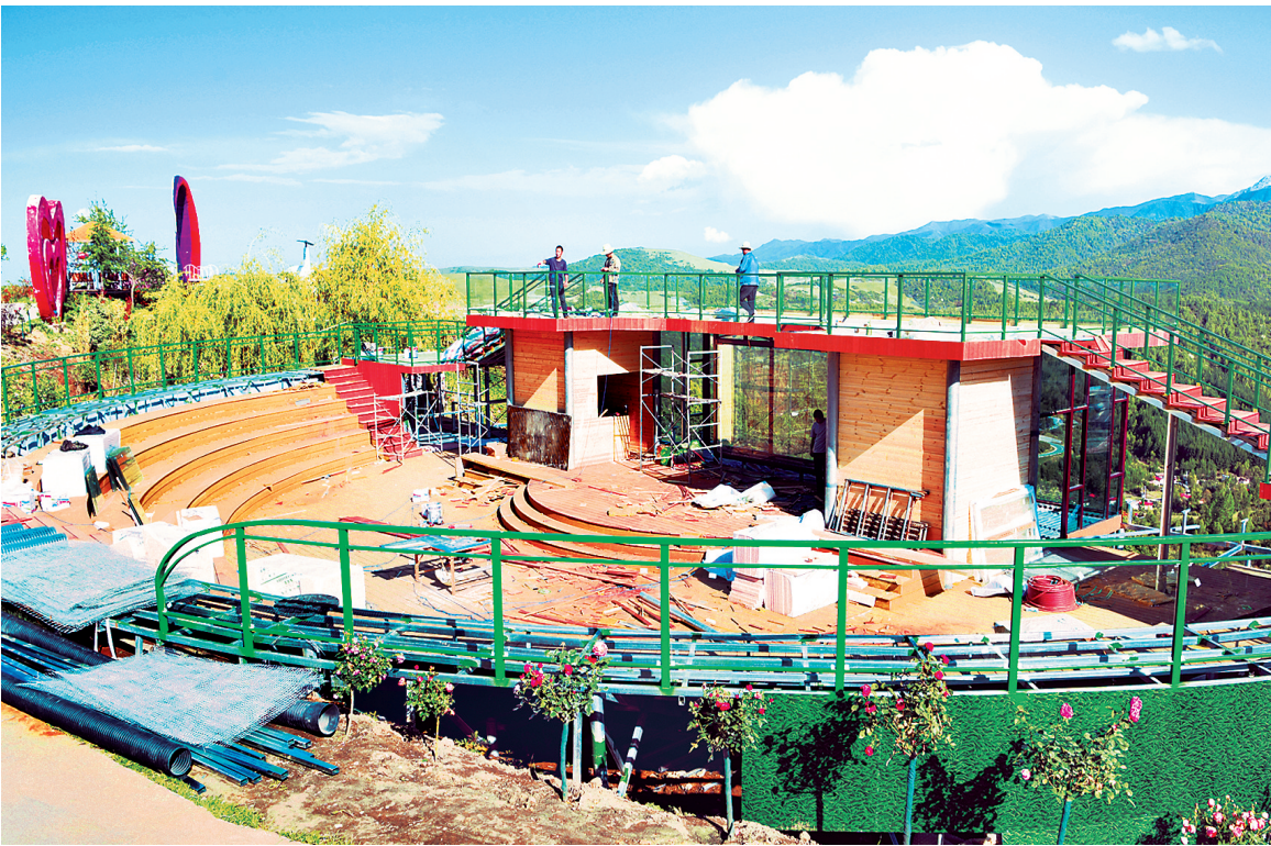
今年，康乐县白桦林景区投资200余万元，新建演艺舞台、观景台、莫奈花园等网红打卡业态。眼下，项目整体施工进度超七成，建成投用后将持续丰富景区游玩内容、提升游客游览体验。 临夏融媒记者 梁永吉 摄
