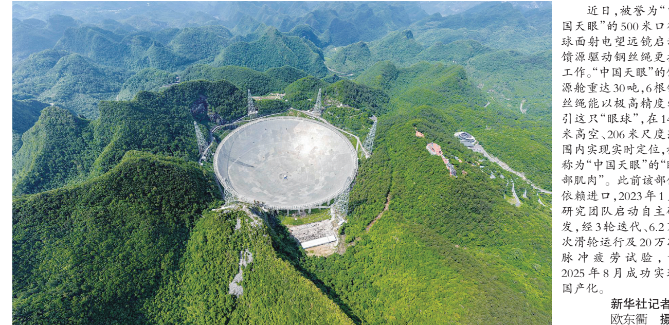
近日,被誉为“中国天眼”的500米口径球面射电望远镜启动馈源驱动钢丝绳更换工作。“中国天眼”的馈源舱重达30吨,6根钢丝绳能以极高精度牵引这只“眼球”,在140米高空、206米尺度范围内实现实时定位,被称为“中国天眼”的“眼部肌肉”。此前该部件依赖进口,2023年1月研发团队启动自主研发,经3轮迭代、6.2万次滑轮运行及20万次脉冲疲劳试验,于2025年8月成功实现国产化。
