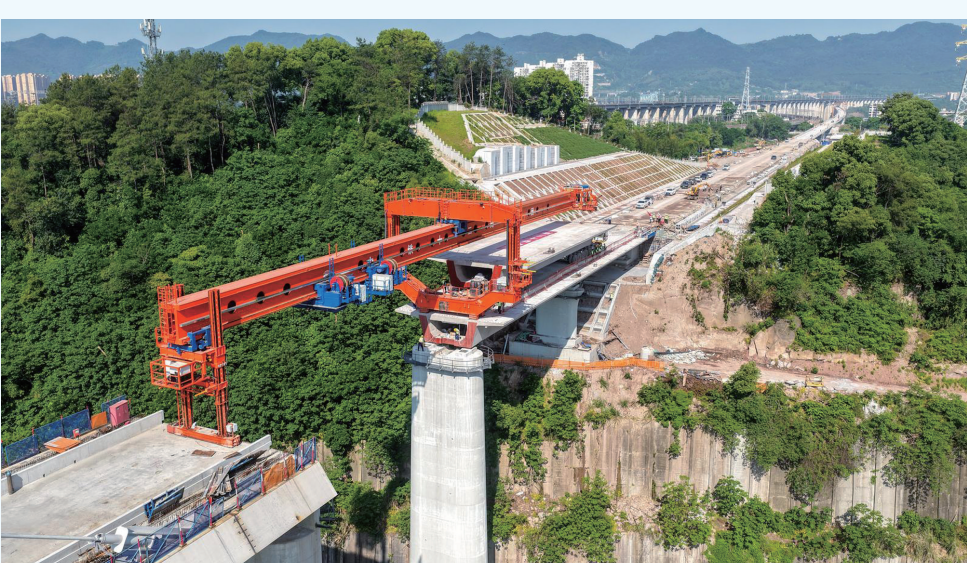
5月5日,随着中铁十二局架桥机将最后一根长32米、重约700吨的箱梁稳稳架设在成渝中线高铁嘉陵江特大桥引桥桥墩上,成渝中线高铁全线箱梁架设任务圆满完成,为项目全线早日通车运营奠定了坚实基础。
