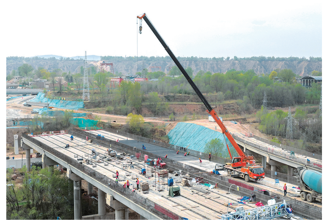
4月11日,由中铁十四局承建的兰永临高速公路重点控制性工程东塬枢纽互通立交加紧施工。该立交位于东乡县东塬乡,是主线与东乡、莲花两条连接线的重要节点,包含11座桥梁,总长约2740延米。 通讯员 史有东 摄
