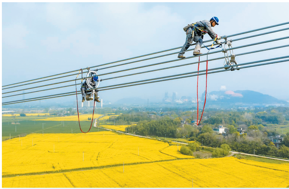
4月1日,在安徽省芜湖市繁昌区内,安徽送变电工程有限公司施工人员在甘肃—浙江±800千伏特高压直流输电工程施工现场作业(无人机照片)。
