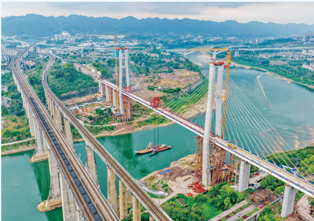
3月31日，由中铁大桥局承建的成渝中线高铁井口嘉陵江特大桥顺利合龙，标志着成渝中线高铁全线桥梁全部合龙，为按期通车奠定了坚实基础。 成渝中线高铁是我国“八纵八横”高铁网沿江通道的重要组成部分，正线全长292公里。 新华社记者 唐奕 摄
