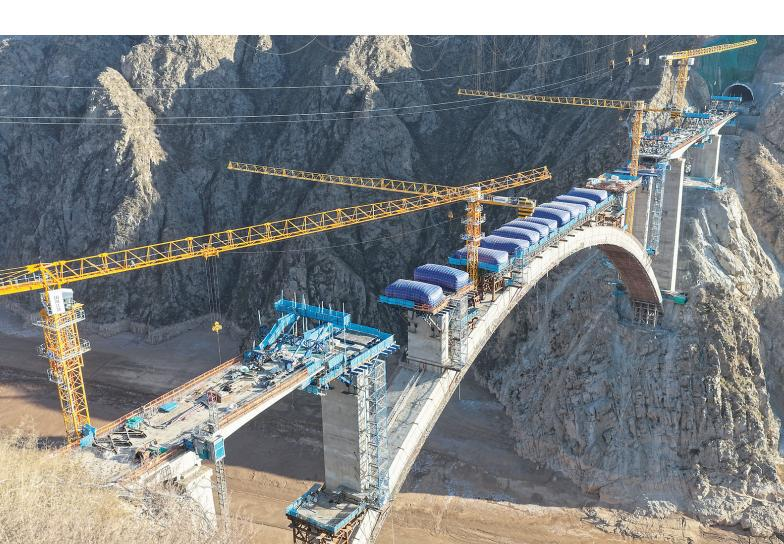
眼下,兰合铁路洮河大桥拱上立柱施工已全部完成,正在进行拱上现浇连续梁施工,为兰合铁路按时通车奠定坚实基础。洮河大桥位于永靖县与东乡县洮河峡谷区,是兰合铁路全线重难点工程,桥梁全长430.5米,主桥为跨径220米的上承式劲性骨架钢筋混凝土拱桥。
