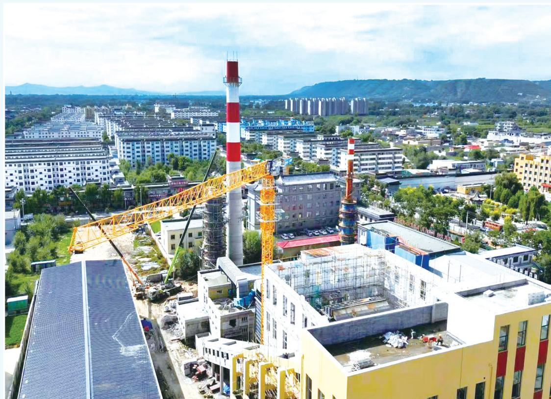
冬季临近,临夏县土桥热源厂提标改造及扩建工程进入收尾阶段。工程建设内容包括安装1台58MW链条式燃煤锅炉,新建锅炉房、引风机房、脱硫设备用房及输煤廊等附属设施。项目建成后,将有效满足土桥镇居民住宅及公共建筑的供暖需求,可覆盖周边设施农业供暖,助力区域生态环境持续改善。
