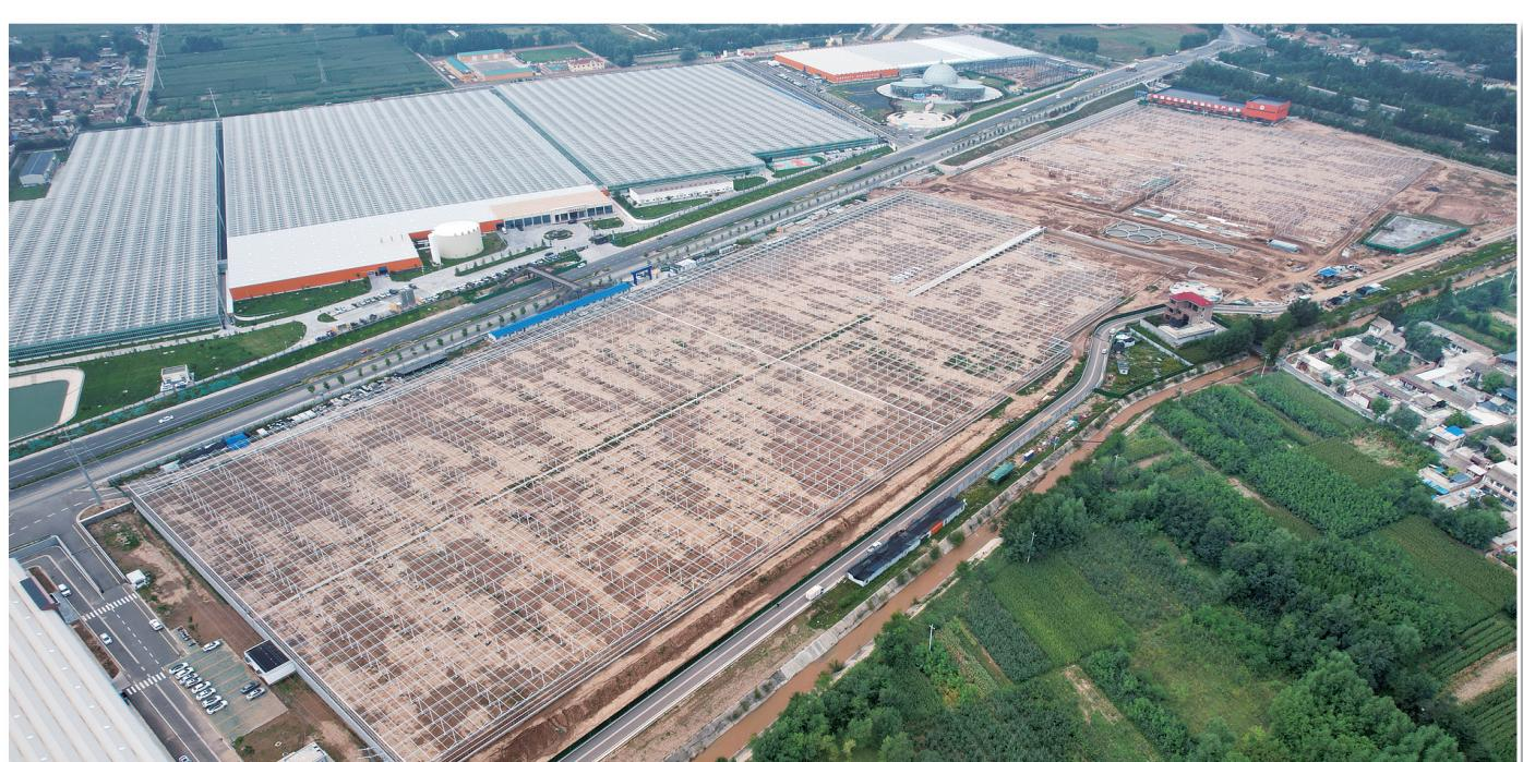
临夏市亿农国际鲜花港建设项目（三期）占地300亩，总投资4.7亿元。目前，该项目两个温室钢架结构安装接近尾声，准备安装温室采暖系统。建成后，将为该市鲜花产业注入新活力。
