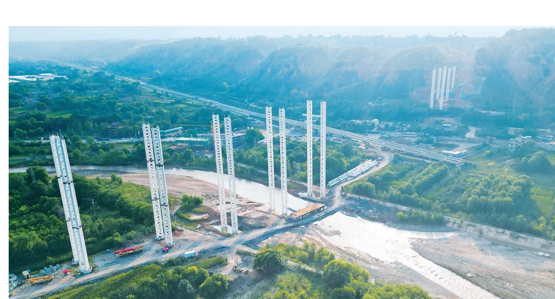
兰永临高速公路大夏河特大桥位于临夏县安家坡乡与东乡县东塬乡之间，是兰永临高速公路的控制性工程，也是国内首例三肢式钢管混凝土格构柱技术使用的桥梁，桥梁全长1409米，建成后将进一步完善我省高速公路网络，对加快区域经济社会发展和资源开发利用等具有重大现实意义。
