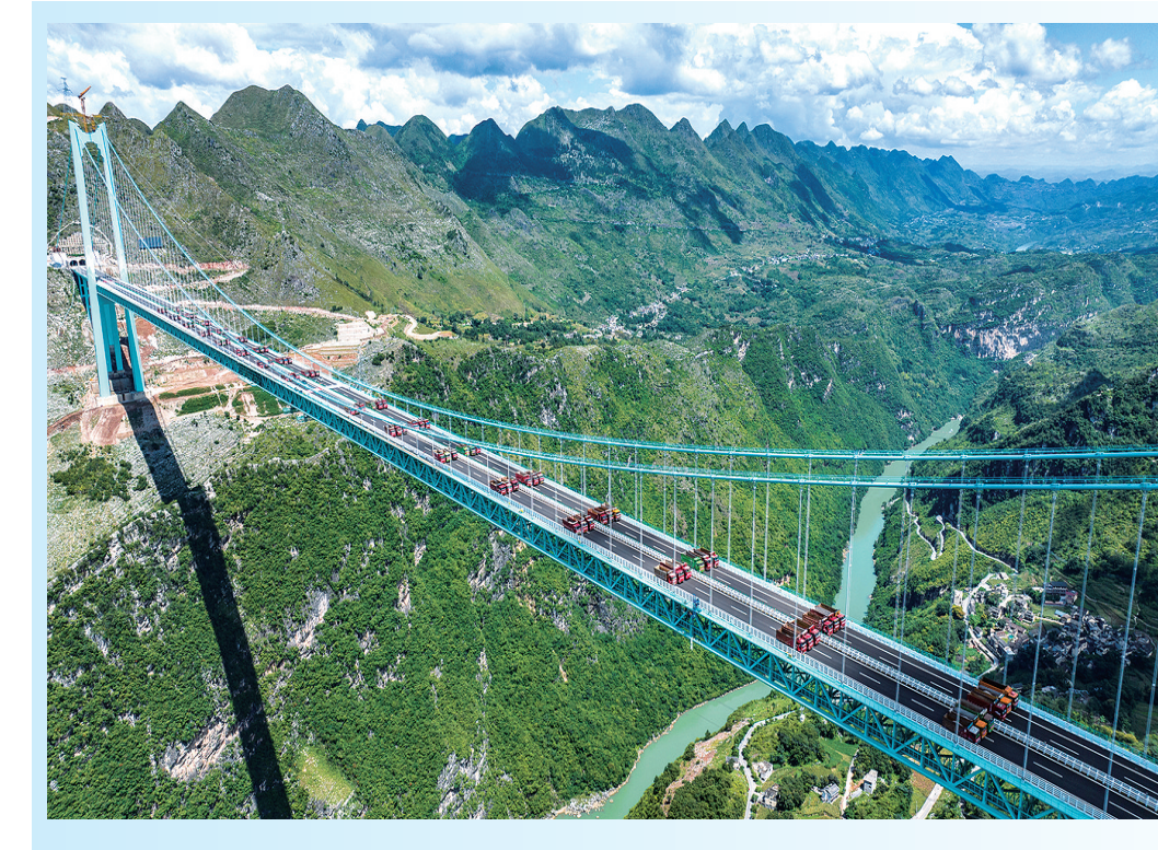
8月25日,在建世界第一高桥——贵州花江峡谷大桥荷载试验顺利完成,通车在即。花江峡谷大桥于2022年1月开工建设,是贵州六枝至安龙高速公路的控制性工程,全长2890米,主桥跨径1420米,桥面到水面高度625米。花江峡谷大桥建成后,主桥跨径将居山区桥梁跨径世界第一、桥梁高度将居世界第一。 新华社发 陈熙 摄
