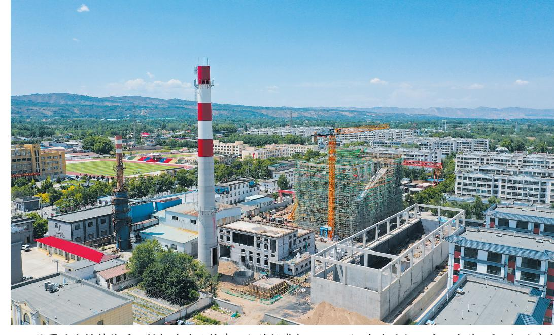
临夏县土桥镇热源厂提标改造及扩建工程总投资超7500万元,占地面积20亩。当前,项目锅炉房主体施工与环保设备安装已基本完成,其余附属设施正加紧推进,全力以赴保障今年冬季如期正常供暖。
