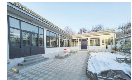
恢复重建全面完成,并通过竣工验收,现已全部入住。该项目的实施,进一步增强了抵御自然灾害的能力,提升了群众的居住条件,改善了居住环境,为和美乡村发展奠定了坚实基础。
