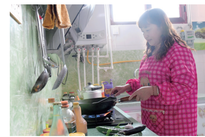
临夏县北塔镇群众用上了天然气。仲冬季节，记者步入临夏市折桥村村民韩刚家，虽然户外冷气逼人，但他家
