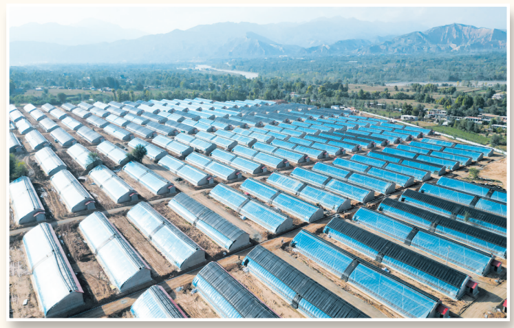
大河镇甘河滩村、梅坡村灾后集中安置点产业扶持(日光温室)建设项目
