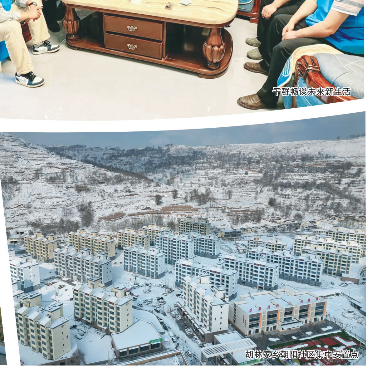
吹麻滩镇城南社区集中安置点
