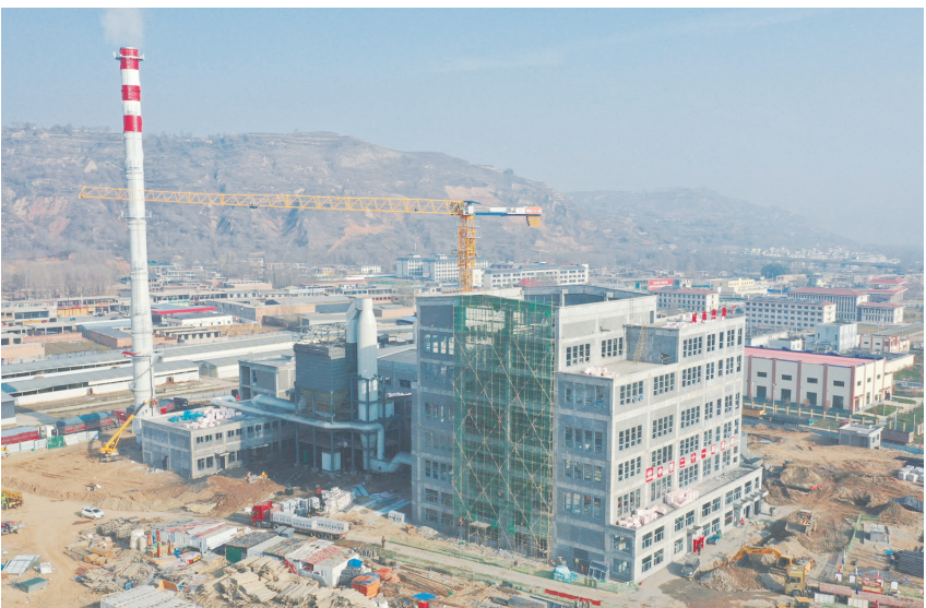
吹麻滩镇城南社区热源厂建设项目
