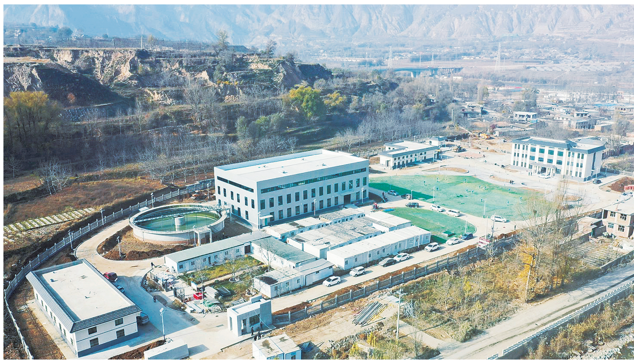
积石山县大河家镇自来水厂项目总投资9161.68万元,建筑面积5440.42平方米,铺设管线约9.1公里,日供水量达7000立方米,可满足大河家镇3200户、2.3万人的生活用水需求,同时为工业发展提供稳定的用水保障。
