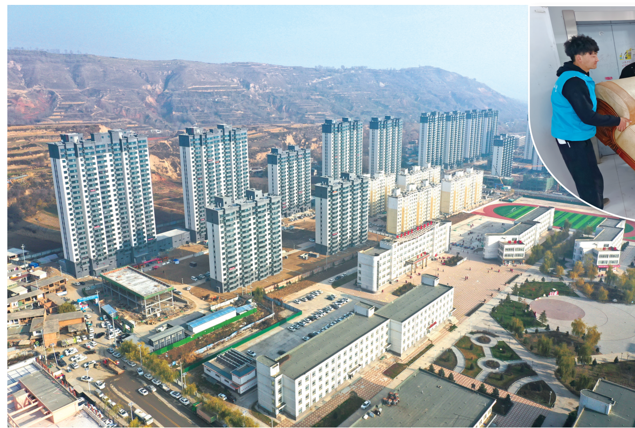
积石山县吹麻滩镇林坪村集中安置点项目总投资15.2亿元,占地240多亩,修建高层住宅楼21栋,安置受灾群众1100户,拆迁群众908户。目前,部分群众已开始搬入入住,开启新生活。 本报记者 梁永吉 摄
