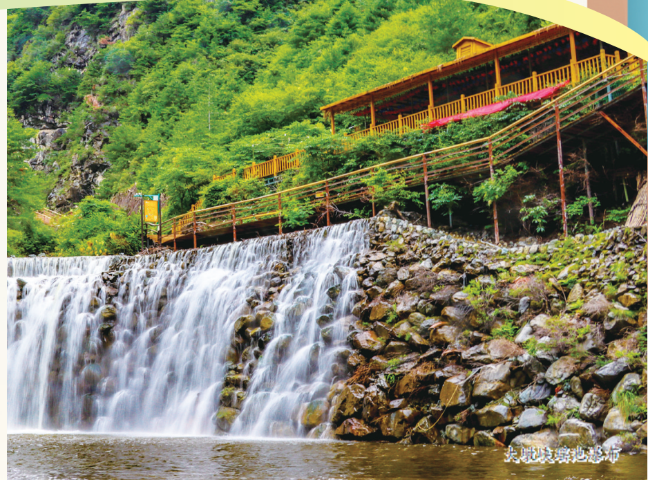
胡林堡乡高关村灾后恢复重建塔合园安置点建设实景
