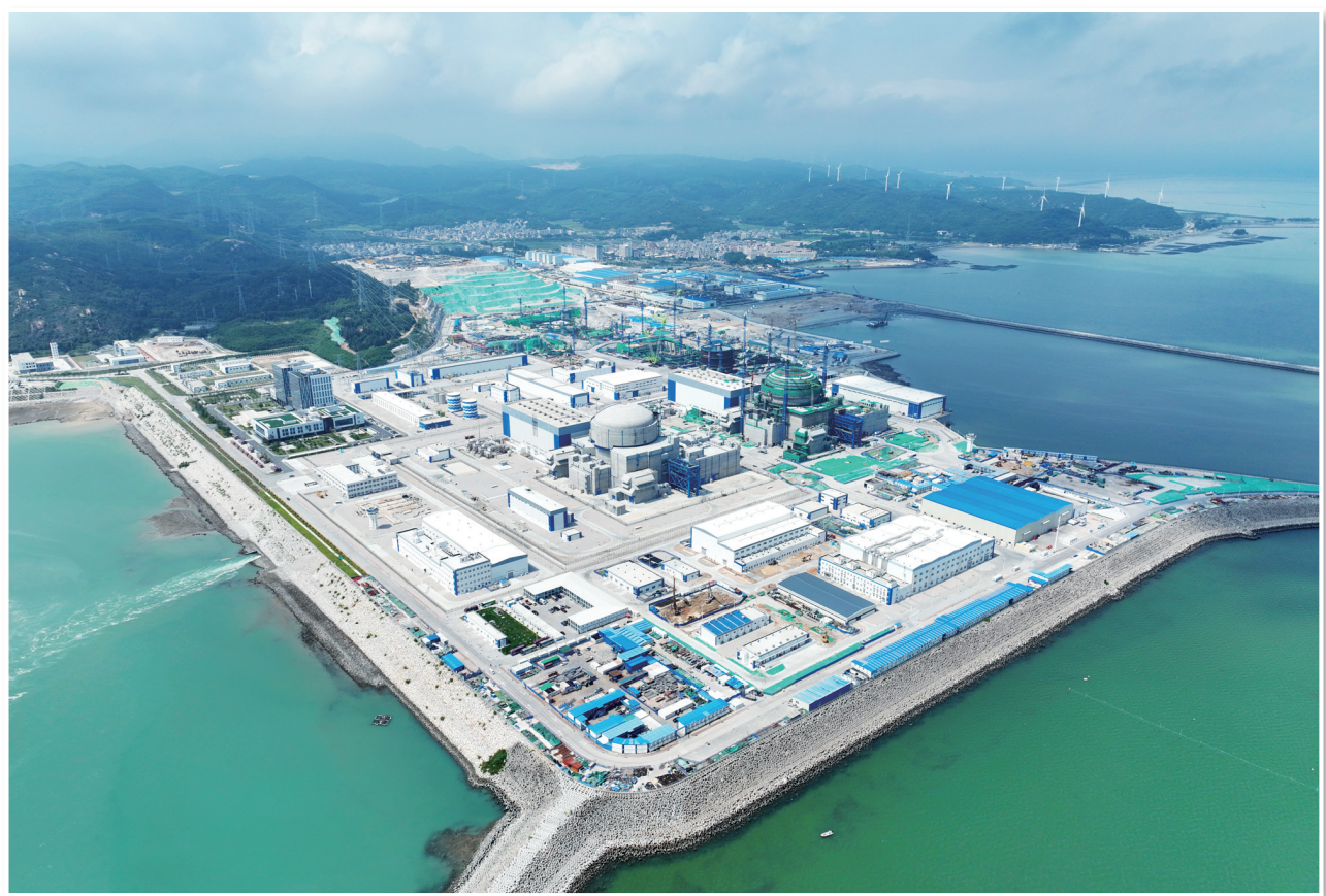
漳州核电4号机组核岛开工 9月27日拍摄的建设的漳州核电站(无人机照片)。当日,“华龙一号”批量化建设再传捷报,中核集团漳州核电二期工程4号机组浇筑核岛第一罐混凝土,标志着漳州核电二期工程建设全面铺开。 新华社记者 林善传 摄
