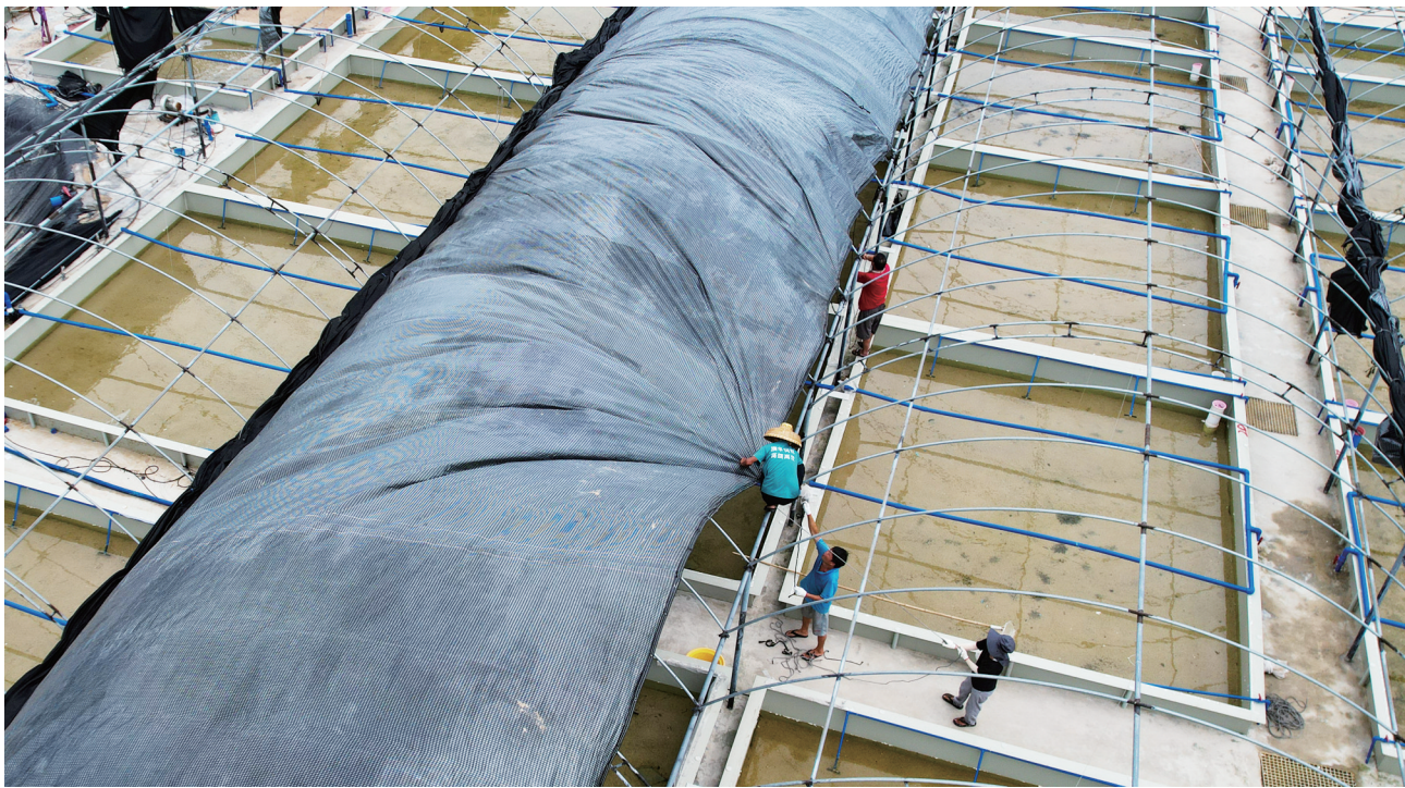
台风“摩羯”过后,海南省推进灾后恢复重建工作,各地积极修复基础设施,协助因灾停产企业复工复产,推动恢复生产生活秩序。图为9月10日,工作人员在位于海南省文昌市翁田镇的海兴农翁田虾苗场重新铺设顶棚(无人机照片)。
