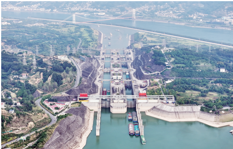
据中国长江三峡集团消息,截至9月3日,三峡船闸今年共计运行6500余闸次,过船2.4万艘次,过闸货运量突破1亿吨。三峡船闸保持高效运行,连续11年实现货运量突破亿吨。 新华社发 王辉富 摄
