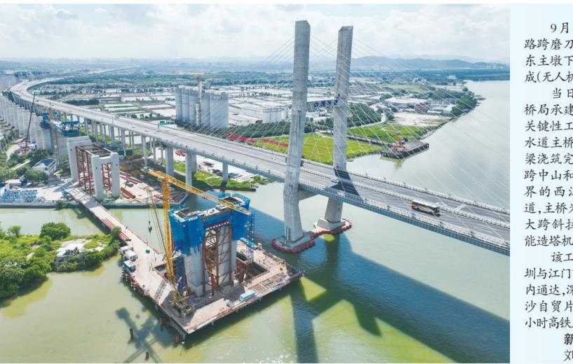
9月1日,深江铁路磨刀门水道主桥东主墩下横梁浇筑完成(无人照照片)。
