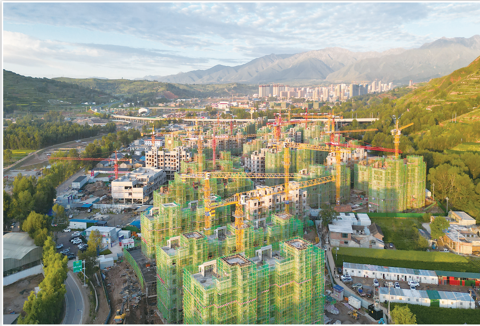
积石山县胡林家乡高关村灾后恢复重建集中安置点建设项目
