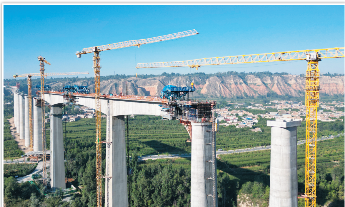
兰合铁路加紧建设
