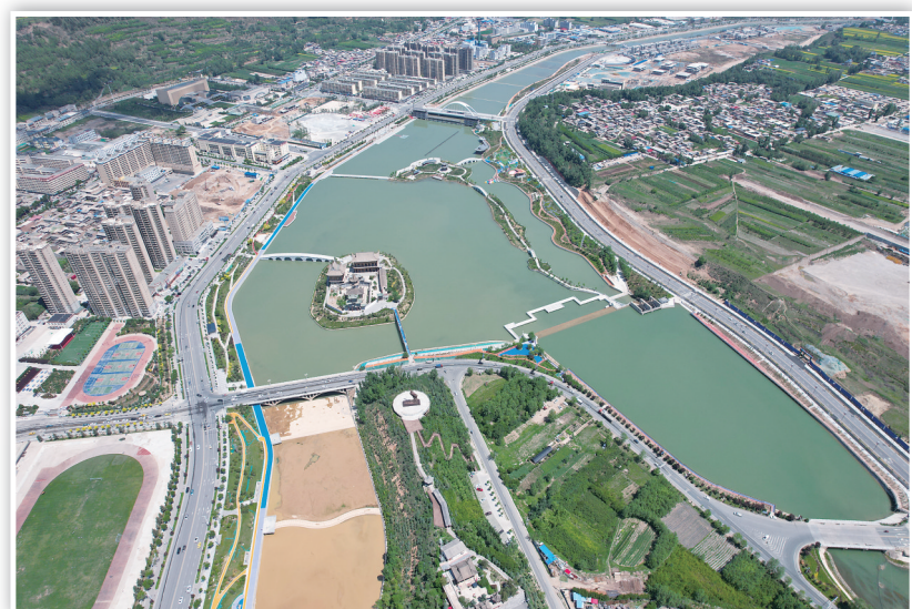
和政县水系连通及水美乡村建设试点工程
