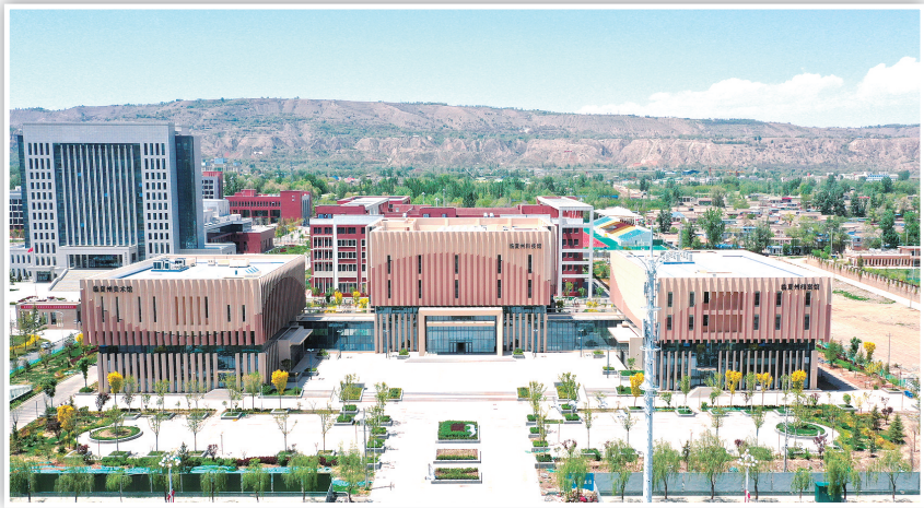
州科技馆、州美术馆、州档案馆
