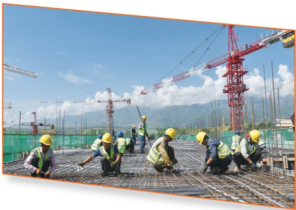
吹麻滩镇城西片区(B区)灾后恢复重建集中安置点建设项目施工现场,工人进行钢筋绑扎作业。
