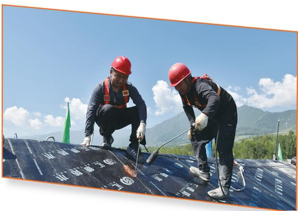
大河家镇陈家村灾后恢复重建集中安置点建设项目施工现场,工人在防水作业。
