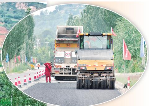
近日,积石山县6.2级地震灾后交通基础设施恢复重建项目G310线临大公路临夏段修复工程全面开工建设。图为临夏公路事业发展中心组织施工单位在G310线K1896+380-830段辅筑上层Ac-13试验段。
