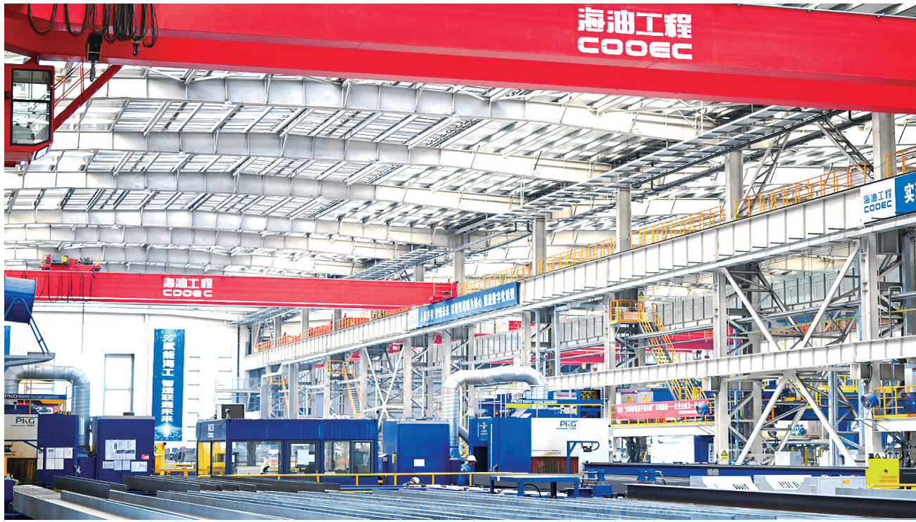
位于天津港保税区临港经济区的海油工程天津智能化制造基地是我国首个海洋油气生产装备智能制造基地,设计年产能8.4万结构吨,拥有海上油气平台导管架、组块、生活楼陆地建造与海上安装、风电项目陆地建造、海管铺设等能力,已陆续为我国渤海海域多个海上油气平台建造单体、组块项目。
