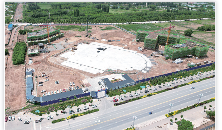
永靖县回民中学、小岭乡旭坪小学灾后易地新建项目
