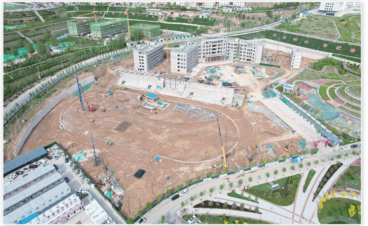
东乡县第八中学建设项目
