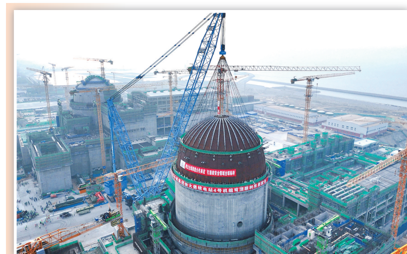
6月18日拍摄的徐大堡核电站4号机组穹顶吊装作业现场(无人机照片)。
