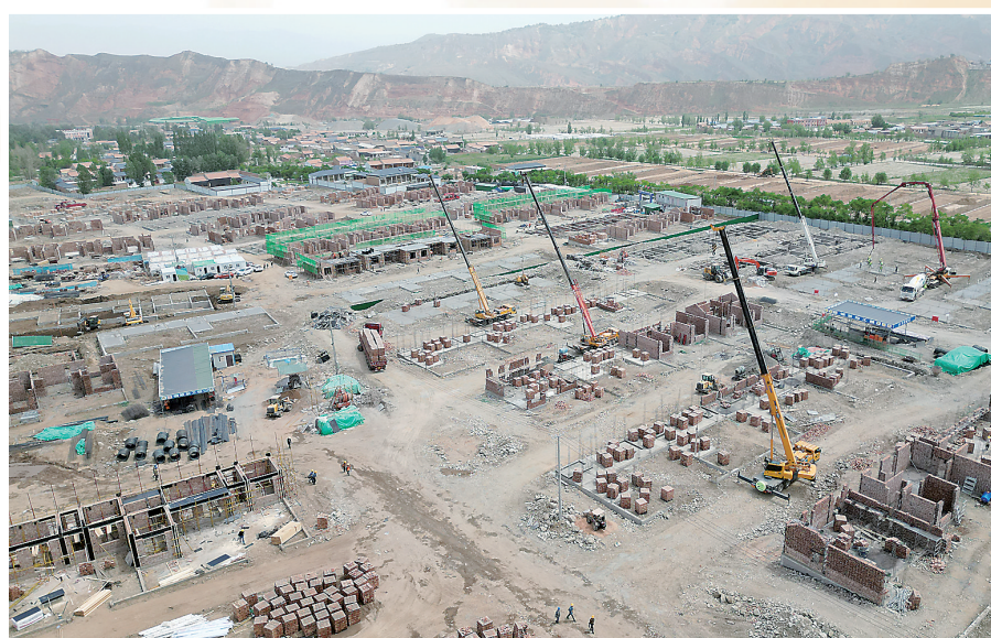
甘河滩村灾后恢复重建集中安置点
