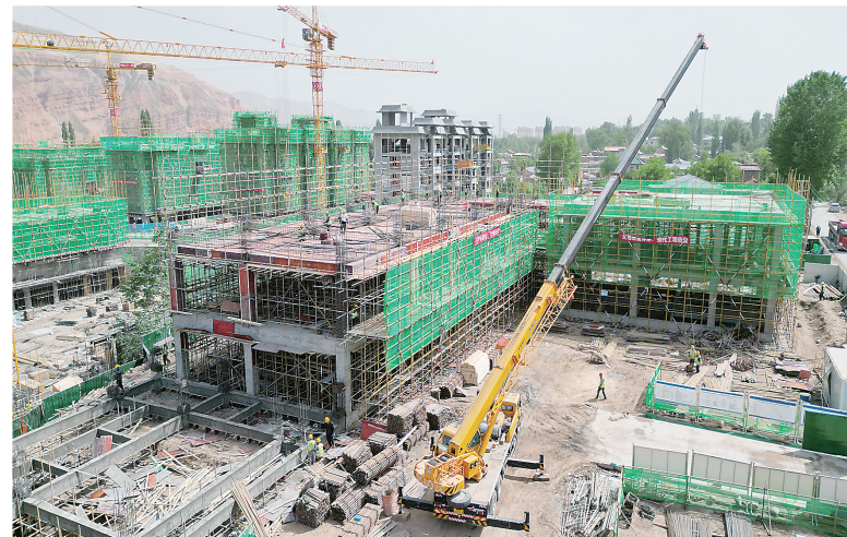
康吊村灾后恢复重建集中安置点幼儿园建设项目
