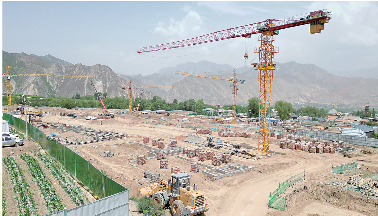
康吊村灾后恢复重建集中安置点
