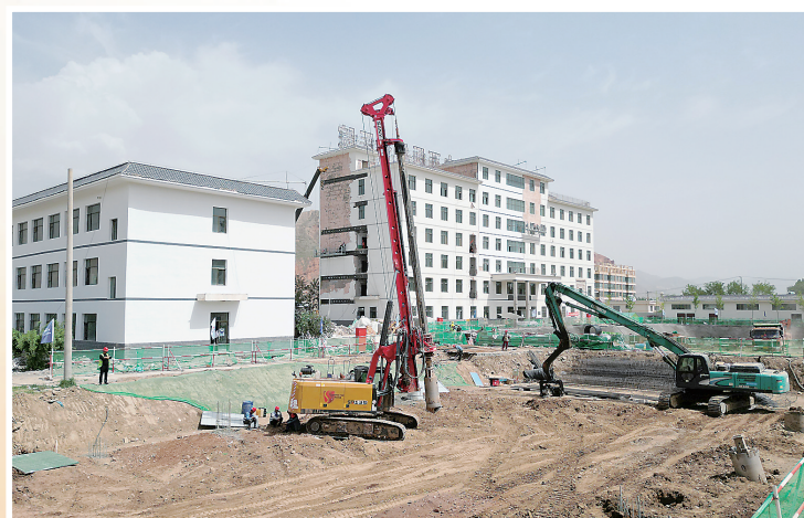
积石山县中西医结合医院建设项目
