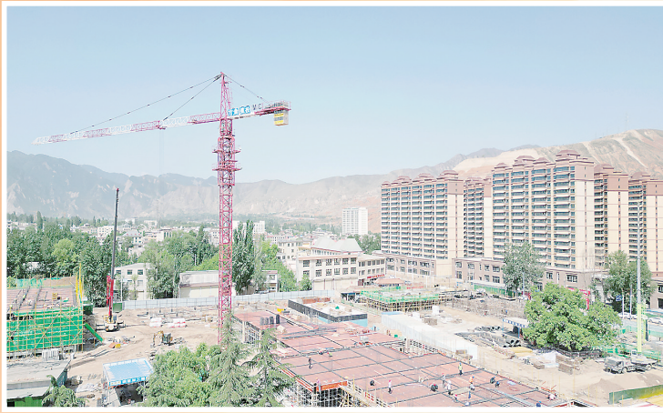
大河家镇五一小学建设项目
