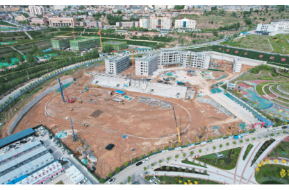
东乡县第八中学建设现场
