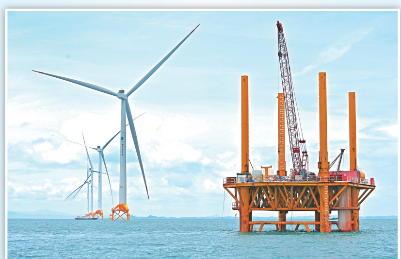
这是海上风电机组施工现场(5月21日摄)。
