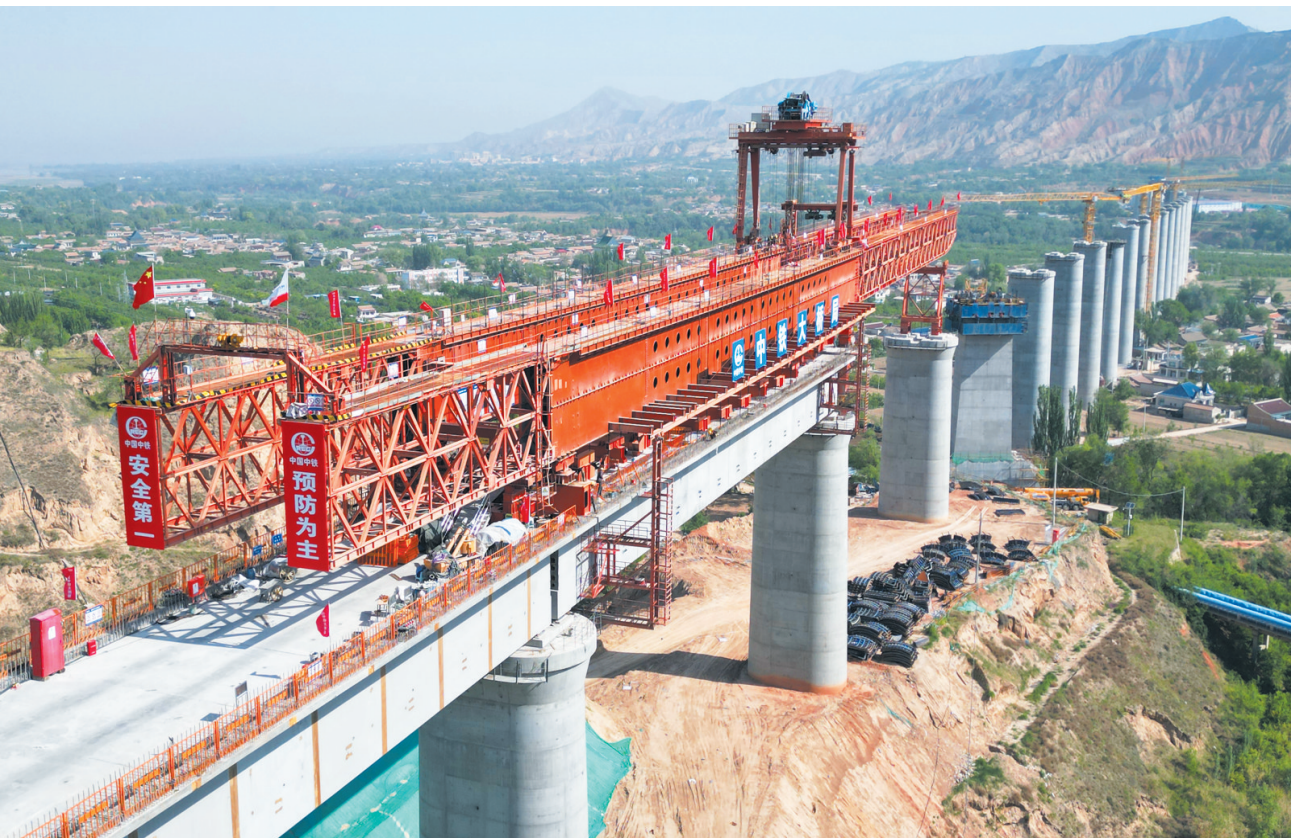
近期,兰合铁路重点控制性工程泄湖峡大夏河特大桥拱梁、T梁、墩身建设全面展开,为后续大桥顺利合龙奠定坚实基础。该大桥横跨临夏大夏河与环库公路,全长4721.45米。图为5月15日拍摄的兰州至合作铁路中桥大桥局4标段泄湖峡大夏河特大桥施工现场。 本报记者 史有东 通讯员 石祥 摄
