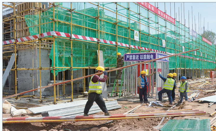
施工现场一级配电箱安装中
