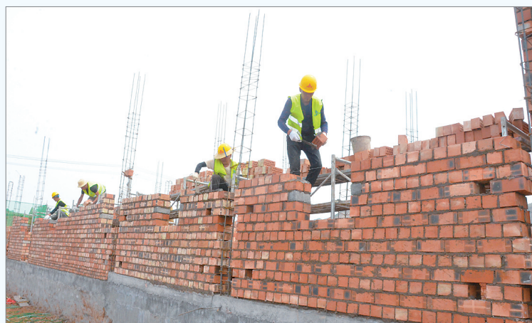
首层砌体作业中
