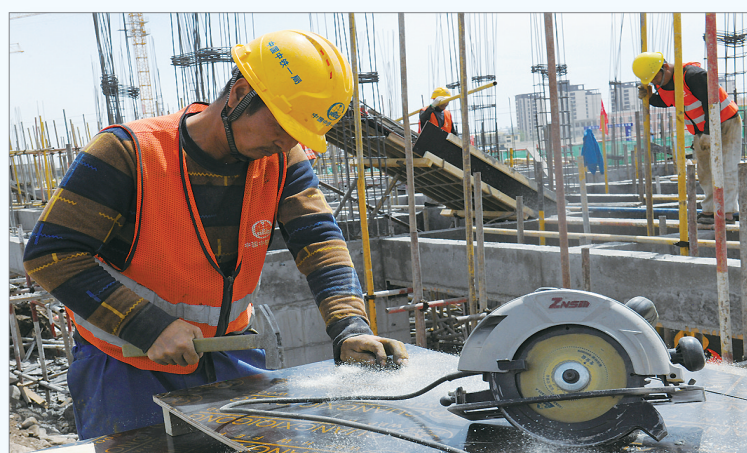
木工班组作业中
