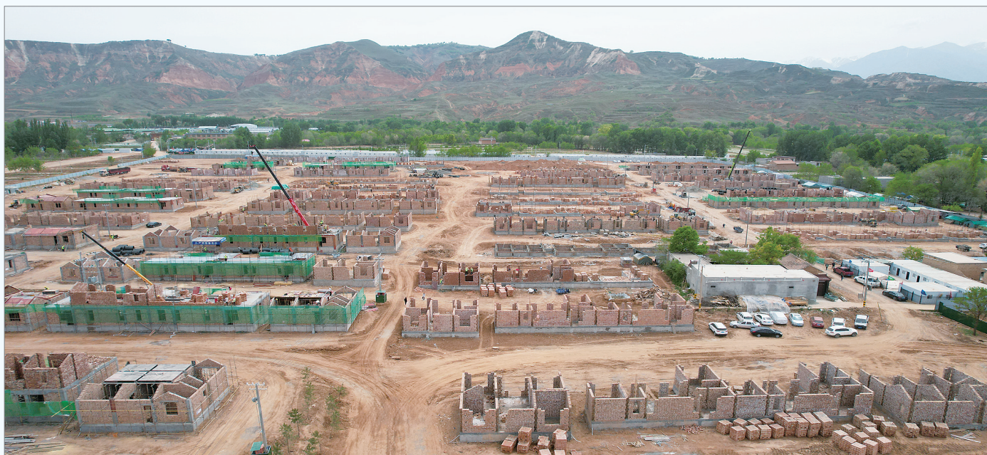
大河家镇陈家村灾后恢复重建集中安置点
