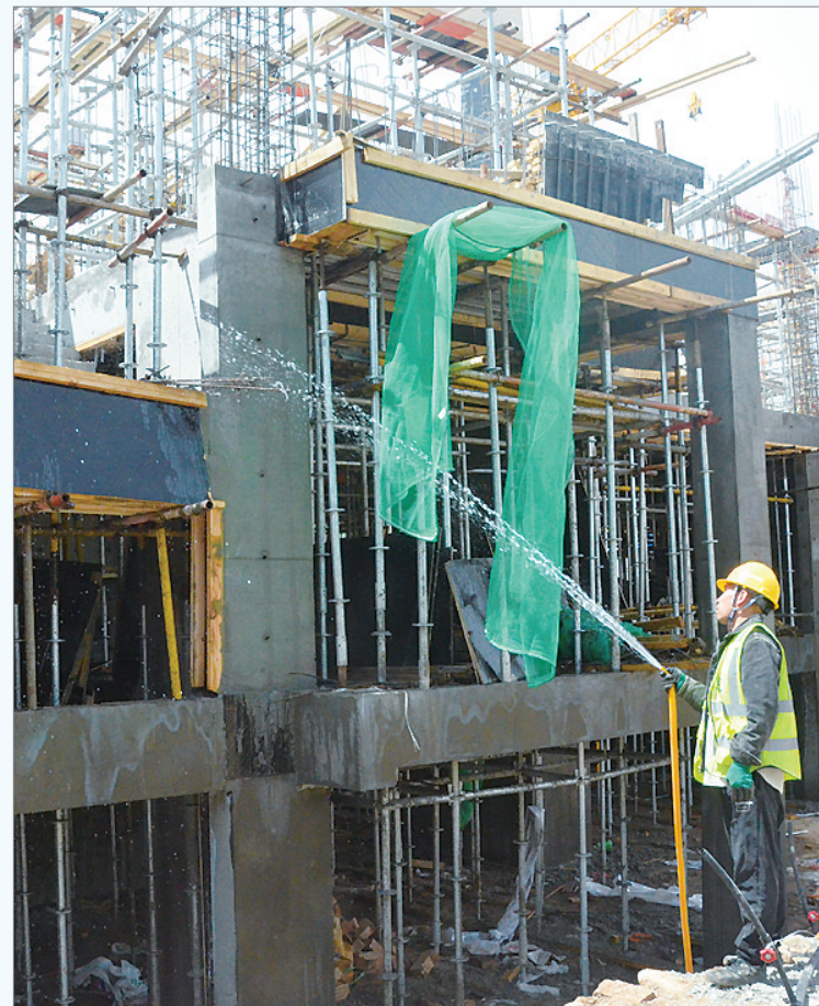
首层墙柱混凝土洒水养护中
