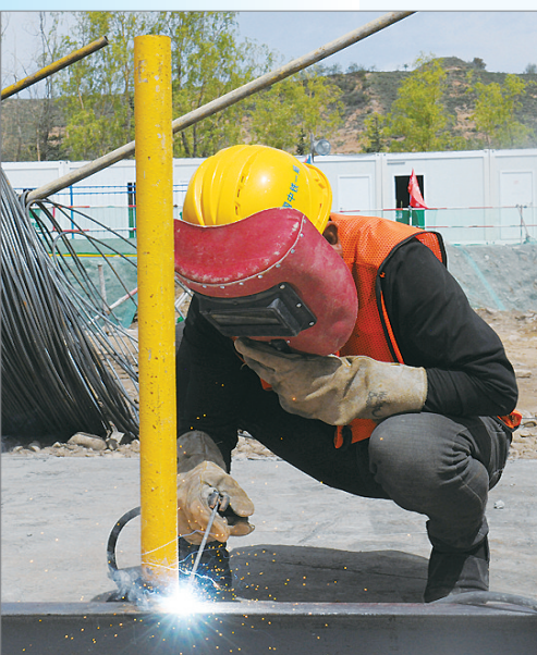
钢筋支架焊接
