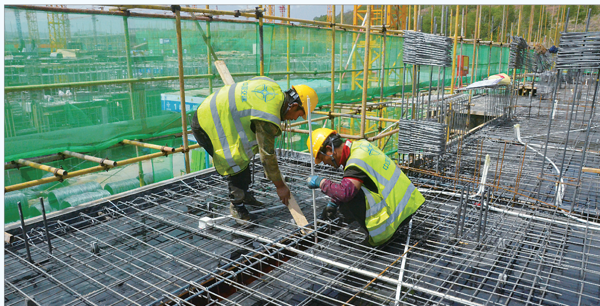
楼层作业面水电线管敷设安装
