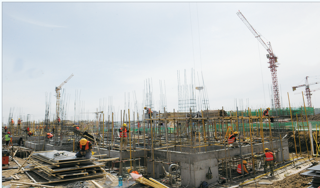
基础模板拆除整理
