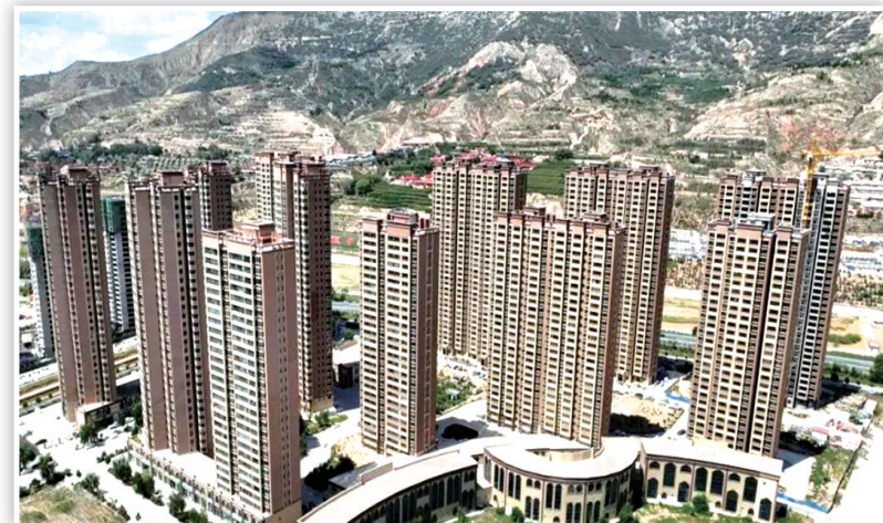
广河县三甲集镇玖家河府小区安置点
