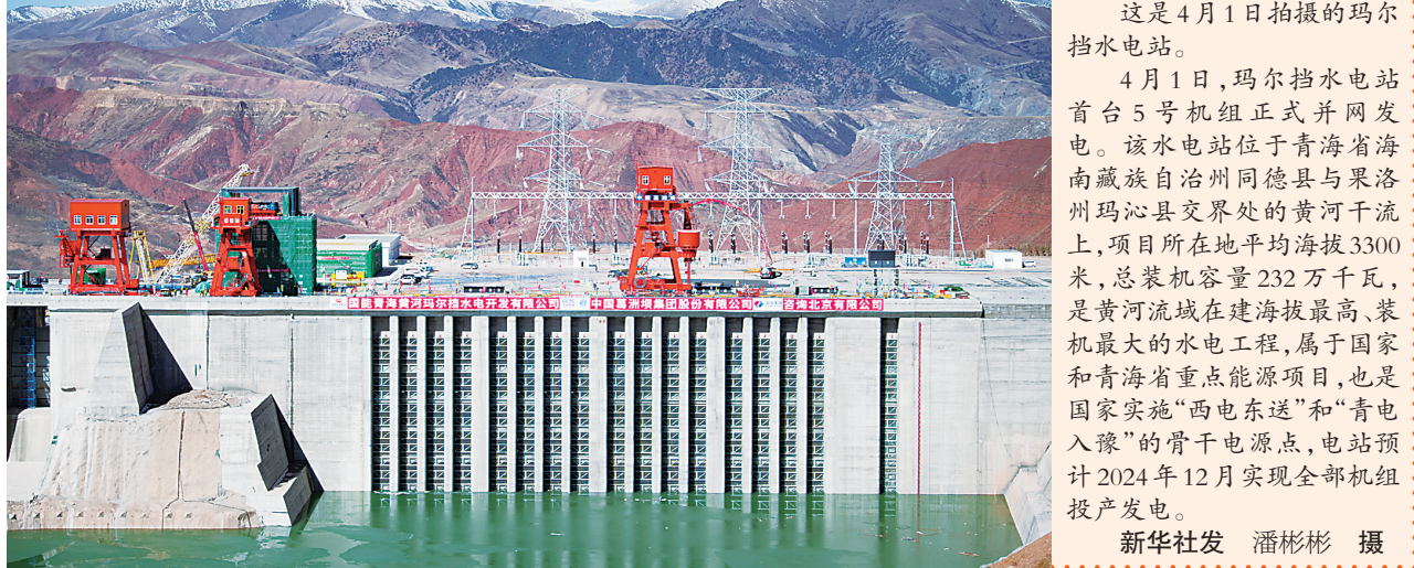
这是4月1日拍摄的玛尔挡水电站。4月1日,玛尔挡水电站首台5号机组正式并网发电。该水电站位于青海省海南藏族自治州同德县与果洛州玛沁县交界处的黄河干流上,项目所在地平均海拔3300米,总装机容量232万千瓦,是黄河流域在建海拔最高、装机最大的水电工程,属于国家和青海省重点能源项目,也是国家实施“西电东送”和“青电入豫”的骨干电源点,电站预计2024年12月实现全部机组投产发电。
