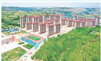
棚户区改造项目
